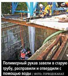
Полимерный рукав завели в старую трубу, расправили и отвердили с помощью воды / ФОТО: ГОРВОДОКАНАЛ
